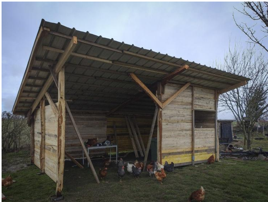
Le volume abrité en fin de gros œuvre, avant bardage complet et finition.
