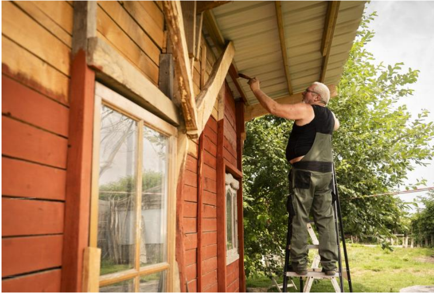
Mise en peinture des rives de toiture à la peinture à l'ocre.
