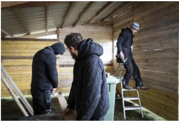
Habillage intérieur en planches.
