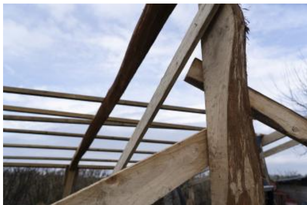
Charpente en bois rond et liteaunage — structure low-tech.
