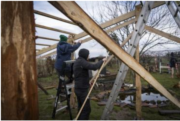
Traçage et pose des pannes.
