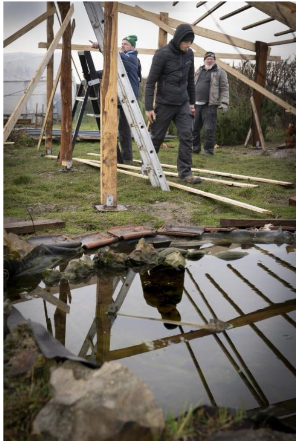
Vue du chantier de charpente.
