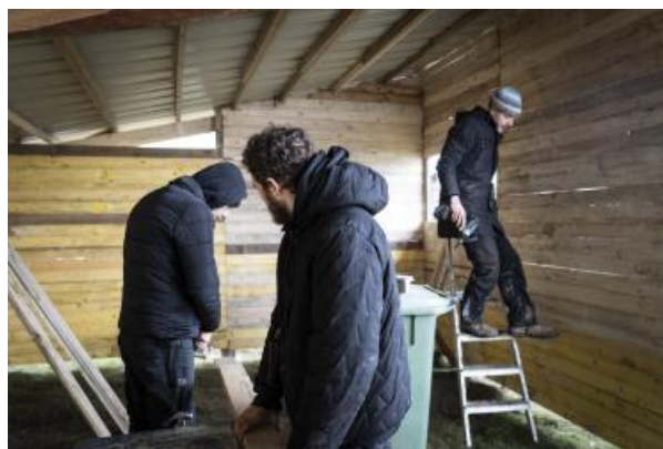
Bardage intérieur en planches.
