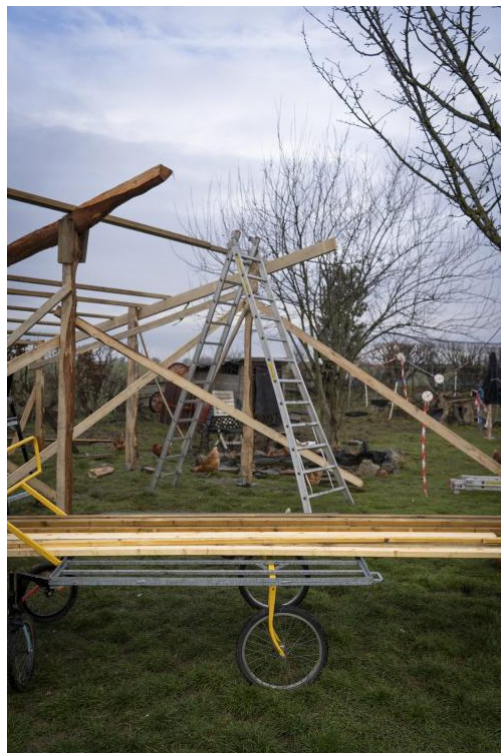
Structure et transport des bois sciés sur site.
