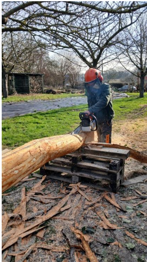
Équarrissage d'un bois destiné à la structure.
