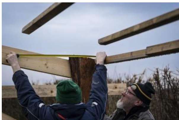
Mesure et ajustement d'une panne sur la structure.
