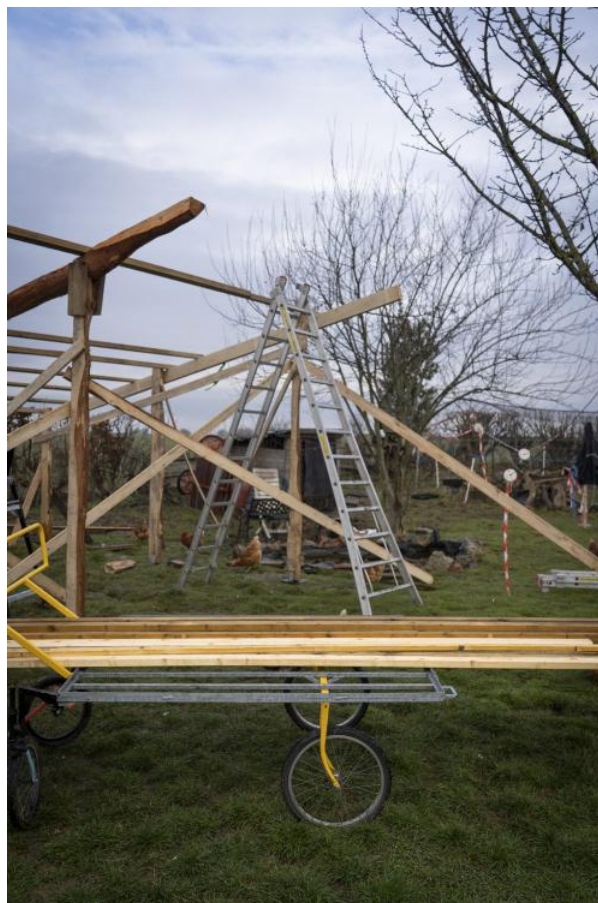
Assemblage de la structure et pose des pannes.
