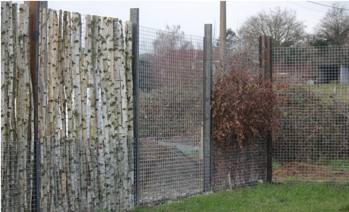
Schnittgut aus dem Garten wird zur Gestaltung der Einzäunungsränder genutzt.
