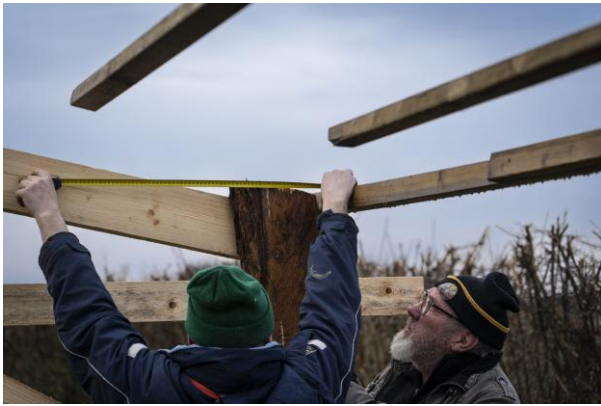
Messen und Anpassen einer Pfette am Tragwerk.
