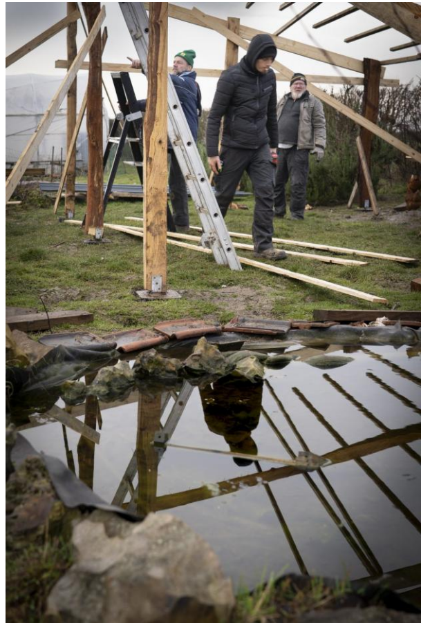
Blick auf die Baustelle der Dachkonstruktion.
