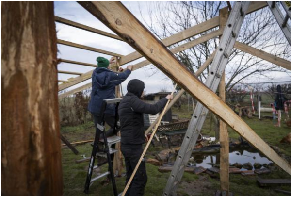
Anzeichnen und Verlegen der Pfetten.
