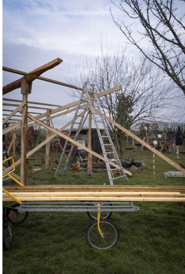
Zusammenbau des Tragwerks und Verlegen der Pfetten.
