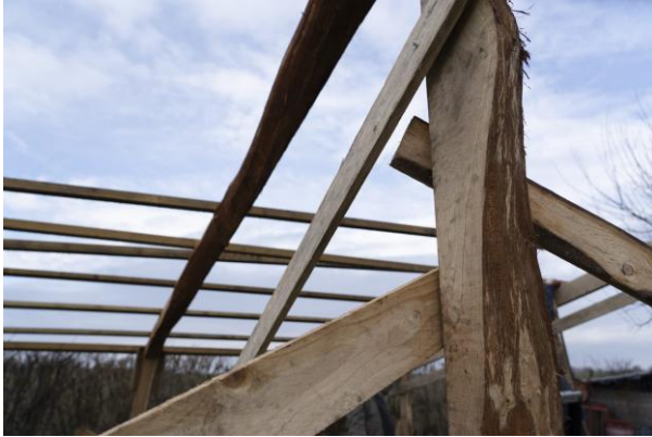
Dachkonstruktion aus Rundholz und Lattung — Low-Tech-Bauweise.
