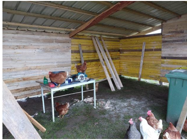
Überdachter Bereich und Zuschnittplatz (Handkreissäge).
