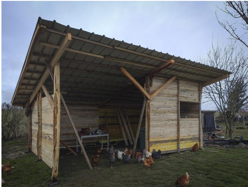
Der überdachte Baukörper nach Abschluss des Rohbaus, vor vollständiger Verschalung und Anstrich.
