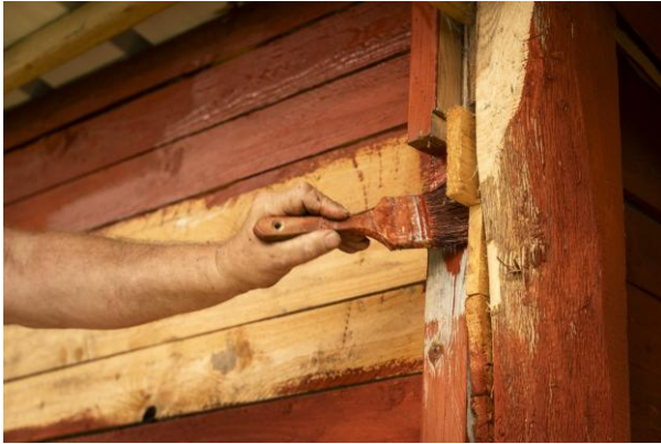
Auftragen der Ockerfarbe auf rohes Holz.
