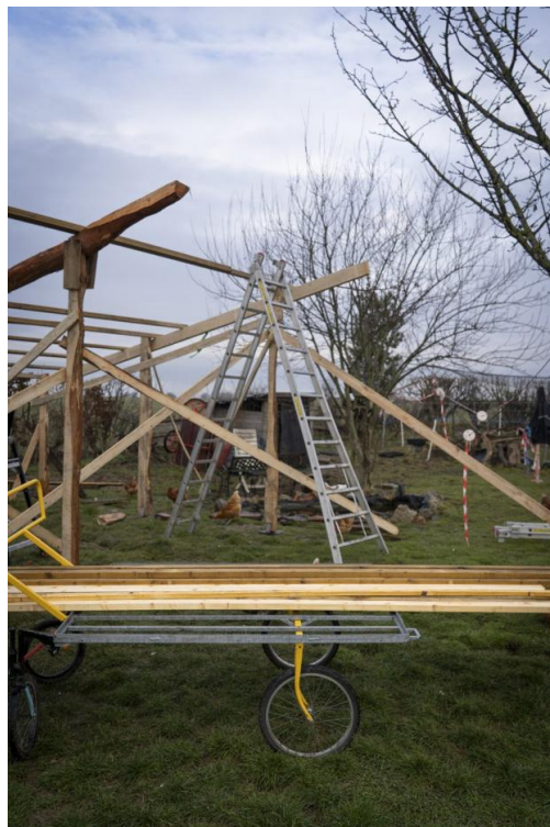
Tragwerk und Transport des Schnittholzes vor Ort.
